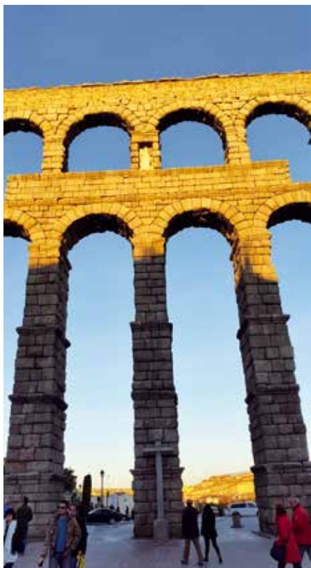
Acueducto en otoño. Noviembre 2017
