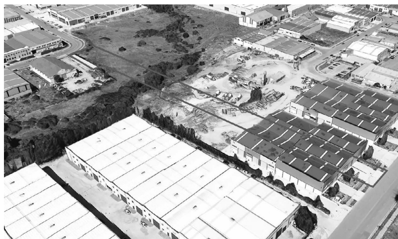
VISTA AEREA DEL TRAZADO DE LA AA.H15, ATRAVESANDO EDIFICACIONES CONSOLIDADAS E INTERRUPIENDO UN CAUCE NATURAL.
