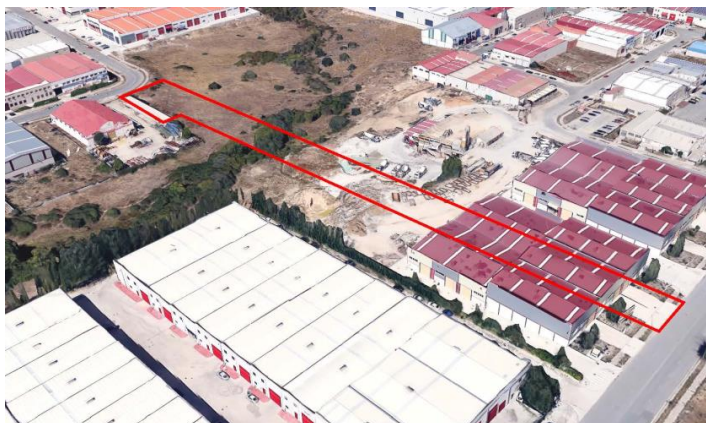
VISTA AEREA DEL TRAZADO DE LA AA.H15, ATRAVESANDO EDIFICACIONES CONSOLIDADAS E INTERRUMPIENDO UN CAUCE NATURAL.
